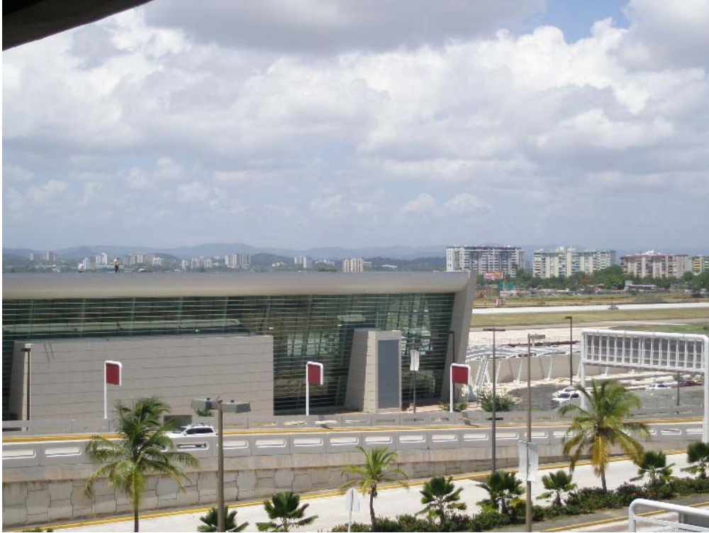
Landseitige Zufahrt Terminal A, Bodendienste und Geräteabstellfläche
